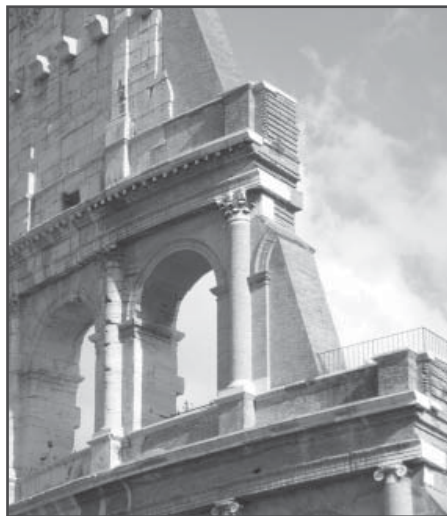
Dettaglio dell’intervento di Giuseppe Valadier all’anello esterno del Colosseo (1821).
