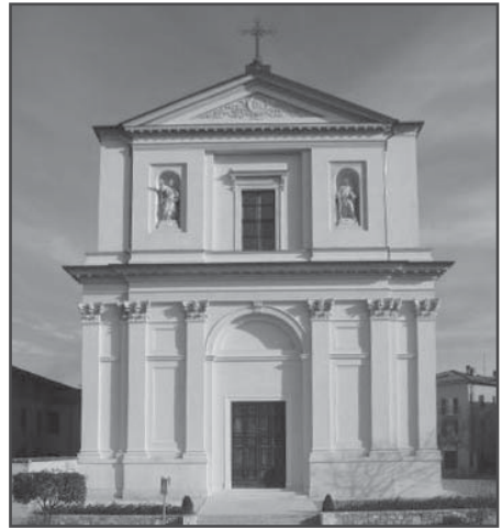
Santa Maria Assunta a Muscoline (BS) al termine degli interventi di restauro.
