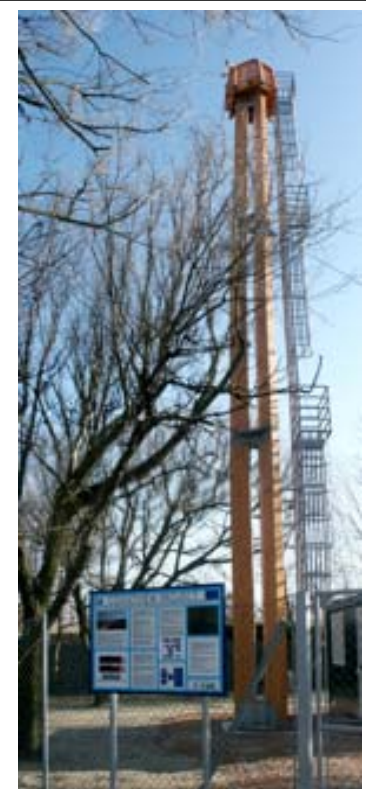
Fig. 4. Torre di monitoraggio del sistema ARGUS
