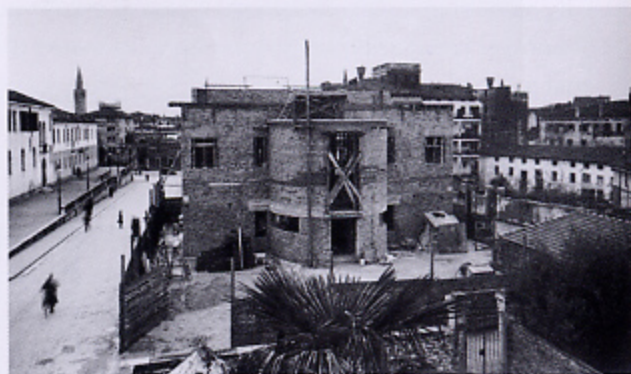
Veduta da nord. Si scorge il corpo pseudoellittico del vano scala.
