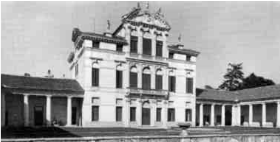
Fronte principale della villa dei Gradenigo ad Angarano.
