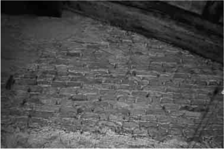
3. Muratura in mattoni pieni della sopraelevazione del sottotetto relativa ai muri di spina.
