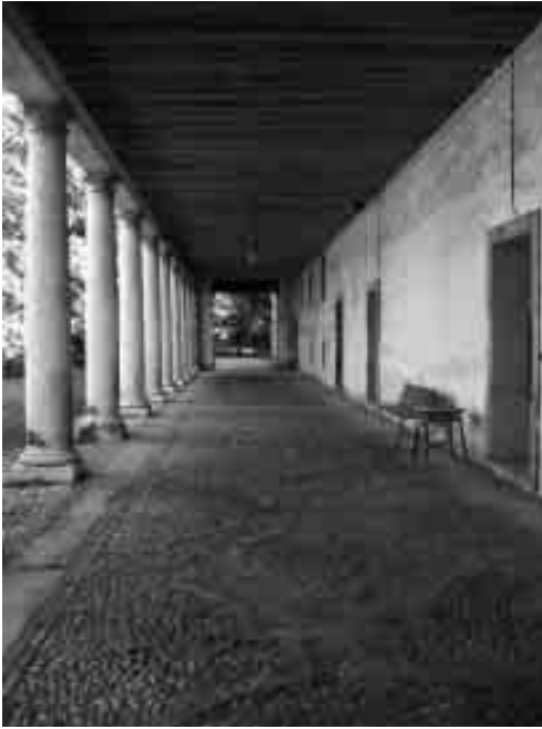
Veduta dell'ampio portico della barchessa seguito dal colonnato dorico. Le decorazioni in cotto nel pavimento in sassi di fiume testimoniano l'uso nobile del portico come luogo per passeggiare.
