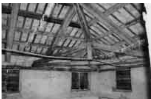
9. Una delle capriate minori all'interno dei quattro vani del sottotetto che permettono l'appoggio dei puntoni angolari e consentono anche di collegare i muri perimetrali.
