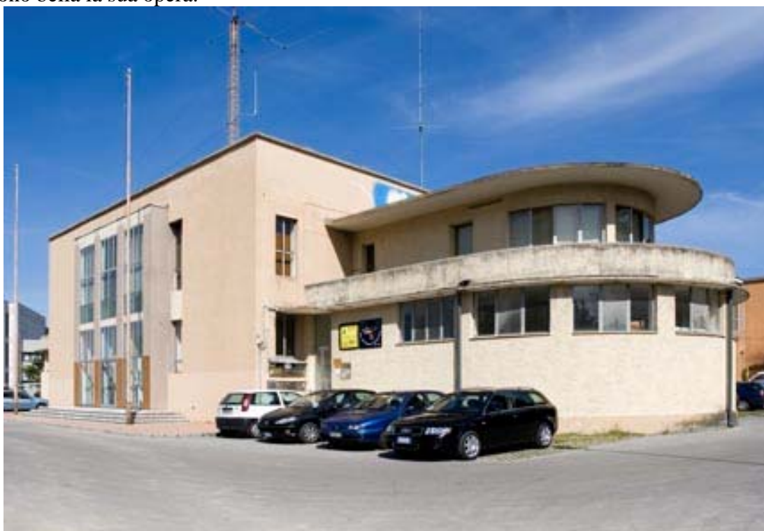
Veduta della Casa del Balilla nelle condizioni attuali
