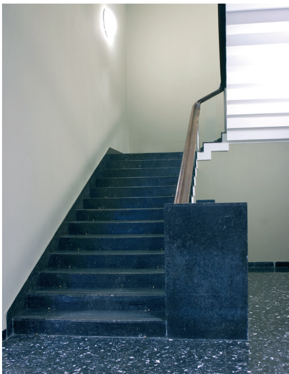
La scala, elegante e razionale, rivestita in marmo grigio conformemente al progetto di Zanini.
