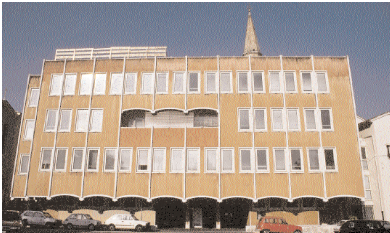
Fronte, su piazzetta Calderari, degli uffici comunali, progettati da Ignazio Gardella.
