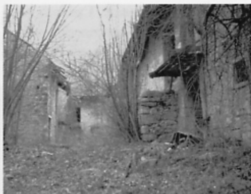
Resti di case a ballatoio a Le Tronconere
