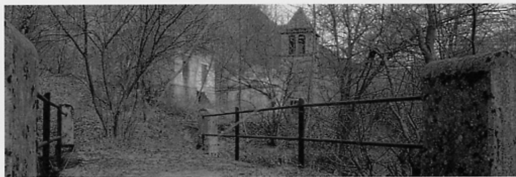
Panoramica di S. Vincenzo dal ponte sul Rio Cual della Barcia
