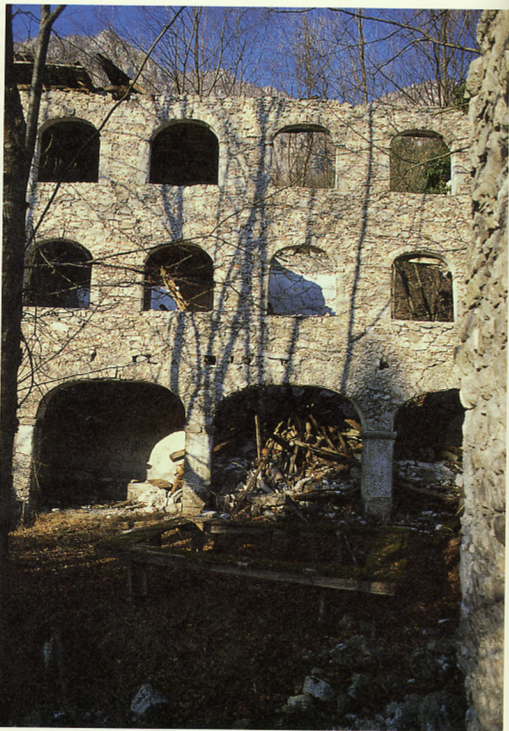
Quello della casa dei Rugo a Vuar non era il solo caso in Val Meduna di edifici residenziali caratterizzati da una doppia loggia sovrapposta al portico del piano terra fabbricati simili, disimpegnati da una scala esterna, erano presenti anche a Palcodea
