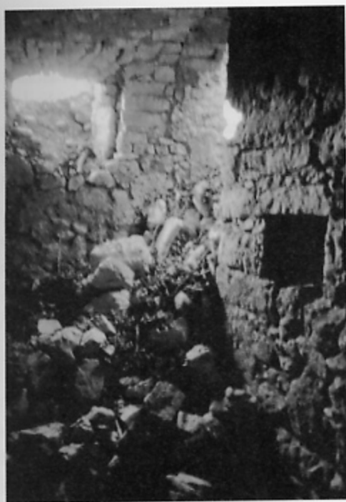
Particolare del magazzino della villa di Domenico Masutti. Le finestre arieggiavano il locale mentre la nicchia in basso a destra ospitava il lume
