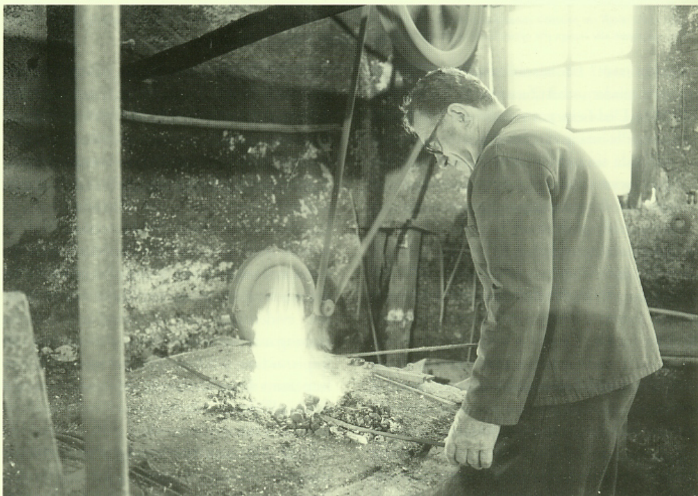
Operazione di riscaldamento del materiale ferroso sulla forgia. L'afflusso di aria sul fornello e sul carbone era garantito da un ventilatore mosso, con un complicato sistema di cinghie e pulegge, da una piccola rosta azionata dall'acqua
