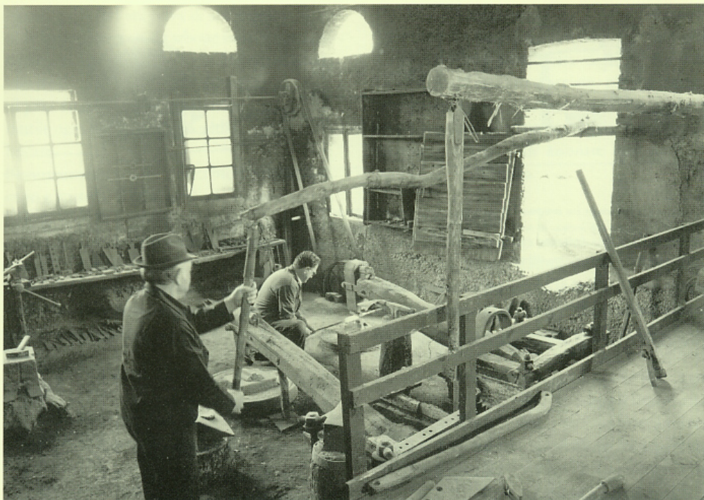
L'utilizzo dei magli era possibile grazie a un sistema di segni che chi operava sul maglio inviava al bocia, impegnato a regolare la velocità della rosta grazie alla stanga che apriva o chiudeva la paratia della vasca di carico
