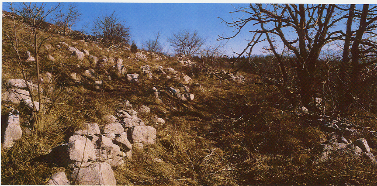
7 - La strada cinta da alti muri in pietrame a Pian delle Salere.
