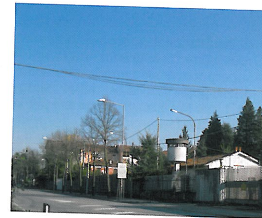
La Trieste e il condominio di alloggi per i militari lungo la Statale 13 / Trieste Barracks and the dwelling building for the military along Route 13. (Franca Carniel)
