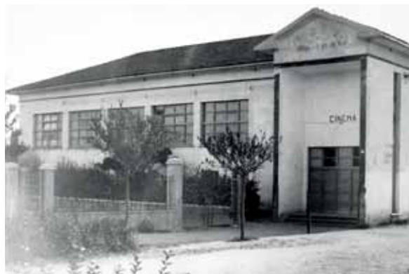
La foto scattata nel primo dopoguerra mostra la recinzione della vicina villa adiacente che sembra chiudere l'ingresso della Casa del Balilla ormai trasformata definitivamente in cinema (ASud, G.I.).
