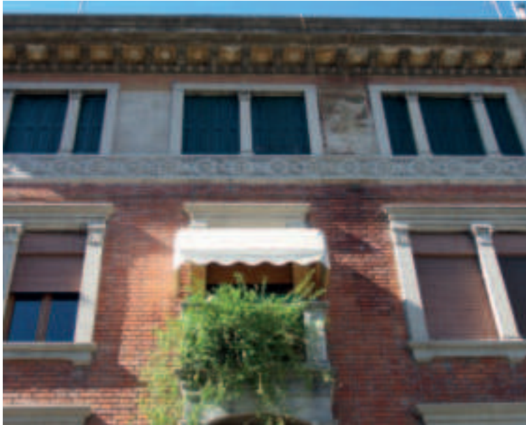
Palazzina Mich in via Mazzini con i materiali in pietra artificiale prodotti a pochi metri di distanza dal laboratorio Salice, 1911
