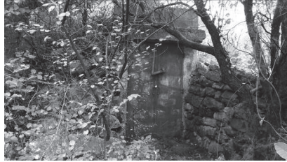
Figura 8. L'accesso a una postazione interrata.
