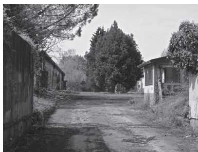
Figura 137. La zona dei depositi prima delle demolizioni.
