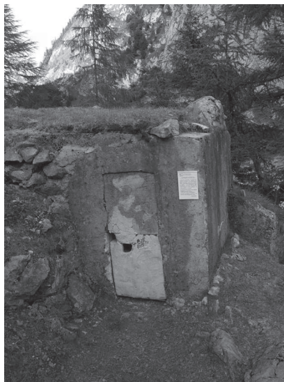
Figura 163. L'ingresso a un'opera delle truppe alpine di arresto.
