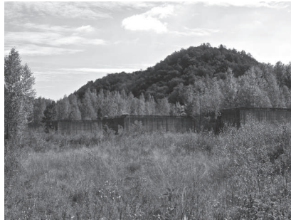
Figura 95. Muri di costruzioni interrotte all'interno del prato della polveriera di Travesio.
