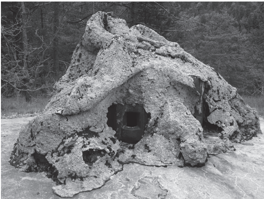
Figura 156. Opere camuffate con l'utilizzo di calcestruzzo.
