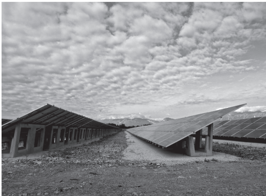
Figura 74. La caserma De Gasperi di Vacile trasformata in un parco fotovoltaico.
