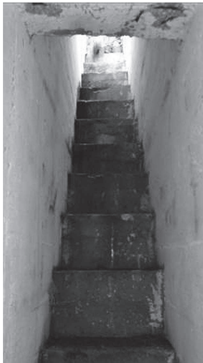
Figura 9. Scala in cemento che collega il bunker con la superficie.
