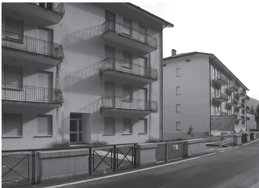
Figura 22. Gli alloggi dei militari oggi disabilitati a Chiusaforte.
