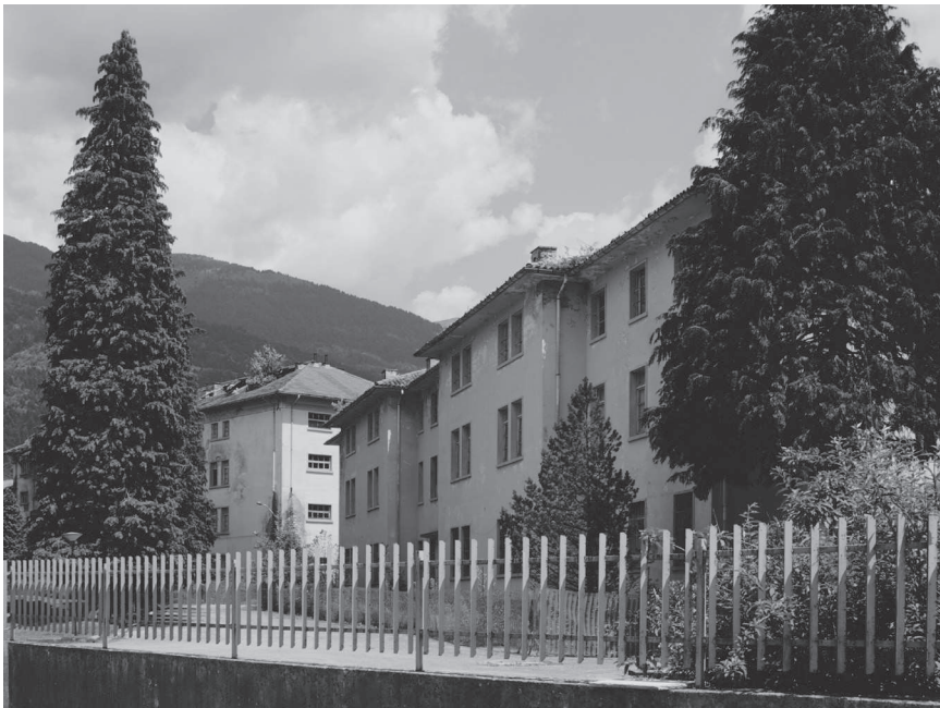
Figura 52. Le coperture delle camerate della Plozner di Paluzza stanno crollando.
