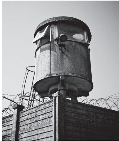
Figura 62. Presidi di controllo abbandonati.
