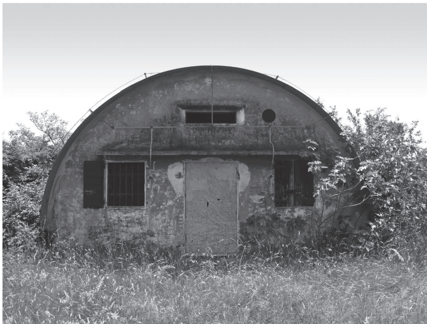
Figura 43. Strutture per il deposito delle armi e delle polveri nella polveriera di Cividale.
