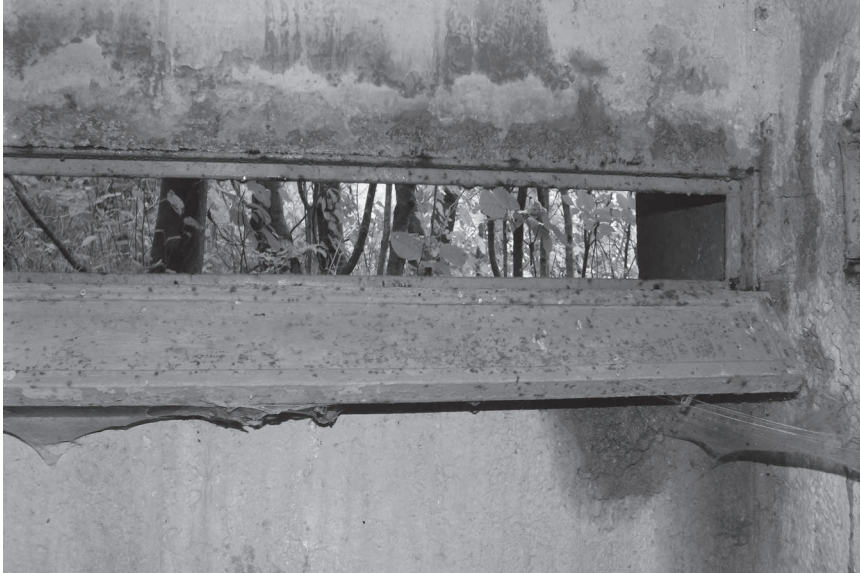
Figura 28. Feritoia di osservazione sul monte Debeli a Doberdò del Lago.
