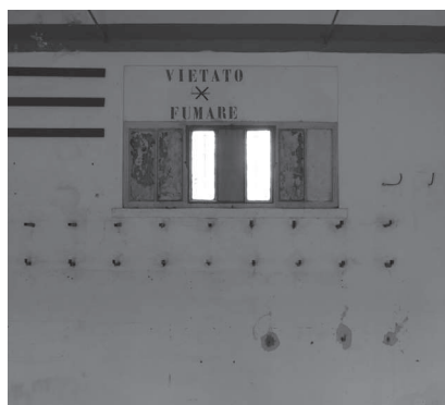
Figura 139. Parete interna della polveriera.
