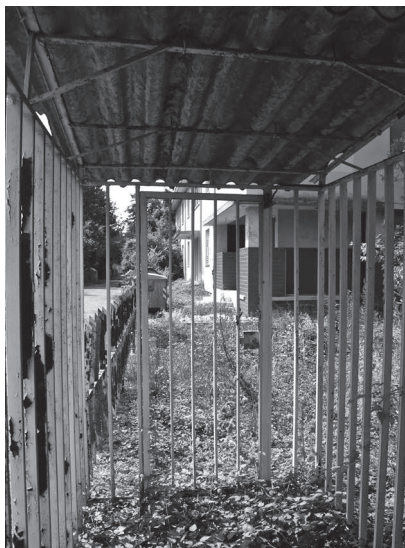
Figura 30. Accesso pedonale alla caserma Miani di Cividale.
