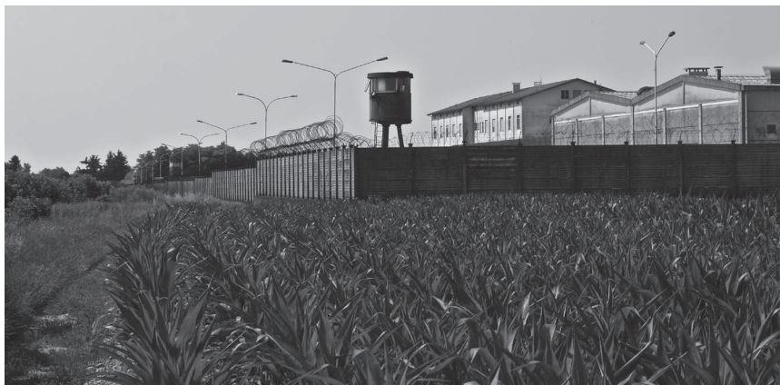
Figura 49. Il perimetro della caserma Lesa a Remanzacco.
