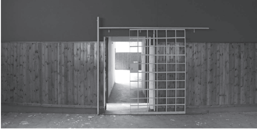
Figura 75. Locali di servizio alla Dardi.
