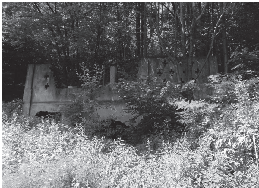
Figura 11. Canal del Ferro, un finto fienile nasconde l'ingresso a un'opera difensiva.
