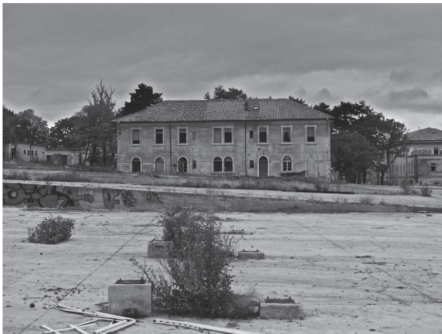
Figura 39. Edifici di servizio nella Caserma Monte Cimone a Banne di fronte a quello che resta delle tettoie che proteggevano i mezzi corazzati.
