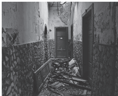
Figura 73. Corridoi alla Monte Cimone di Trieste.
