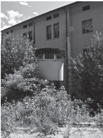
Figura 68. Altana presso l'accesso carrabile della Bertolotti di Pontebba.
