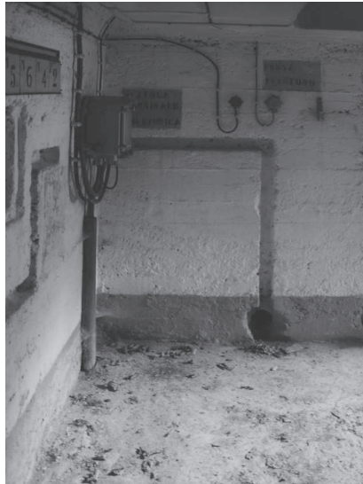
Figura 50. Ingresso di un'opera nei pressi di Pontebba.
