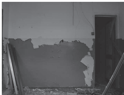
Figura 164. Locale del corpo di guardia della polveriera di Travesio.
