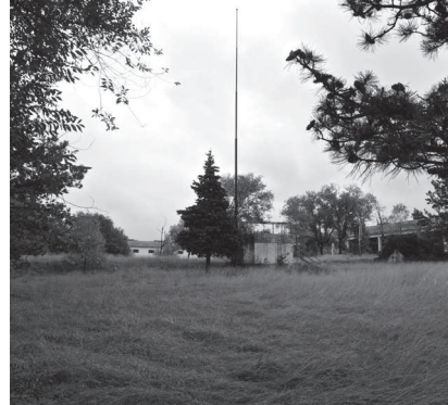
Figura 45. Caserma Dardi e il piazzale delle adunate invaso dalla vegetazione.
