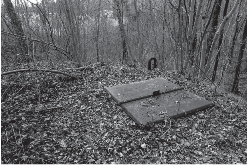
Figura 102. Nel comune di Trasaghis si possono ancora vedere le postazioni scavate nella roccia e quelle seminterrate. Qui si vede il portellone di entrata ad una di queste ultime: è costruita in solido cemento armato e, se non ricordo male, conteneva una torretta di carro armato.
