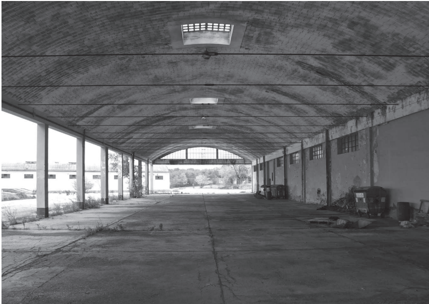
Figura 44. Autorimessa alla caserma Dardi di Sgonico.
