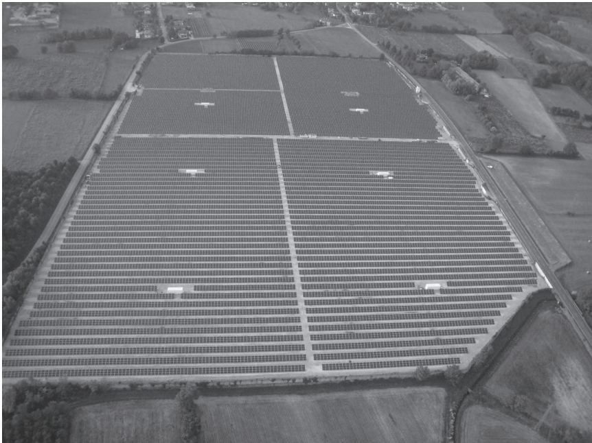
Figura 18. e 19. Il recinto della caserma completamente riempito di pannelli fotovoltaici.
