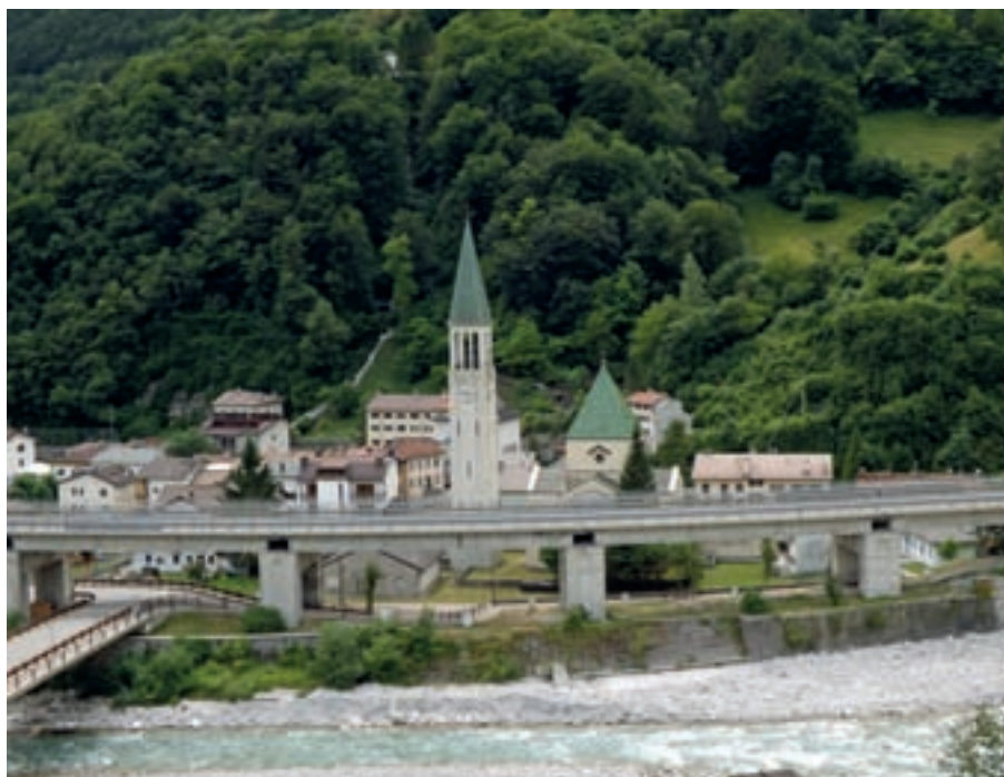
Il viadotto di Dogna si pone come una frattura tra il fiume e l'abitato (Foto di Moreno Baccichet, 2013)
