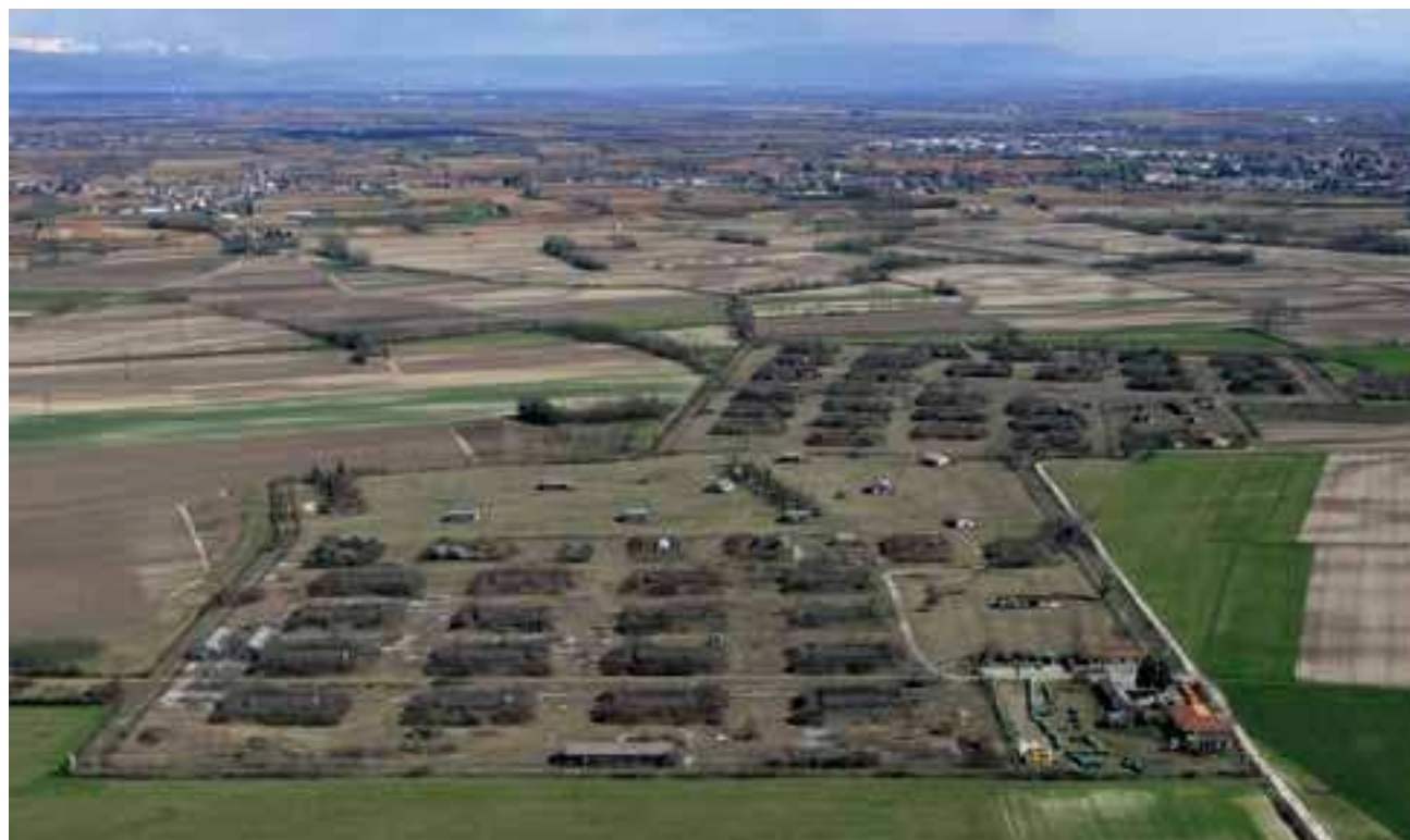
La ex polveriera Coseat-Brunner in località Prati di Loreto (Codroipo). Dismessa alcuni decenni fa, è stata ceduta gratuitamente nei primi anni 2000 dal demanio militare al Comune di Codroipo. Si tratta di quasi 40 ettari. Fotografia di Stefano Zanini.
