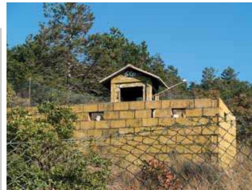
Postazione di controllo con garitta sul Carso monfalconese. Fotografia di Walter Coletto.
