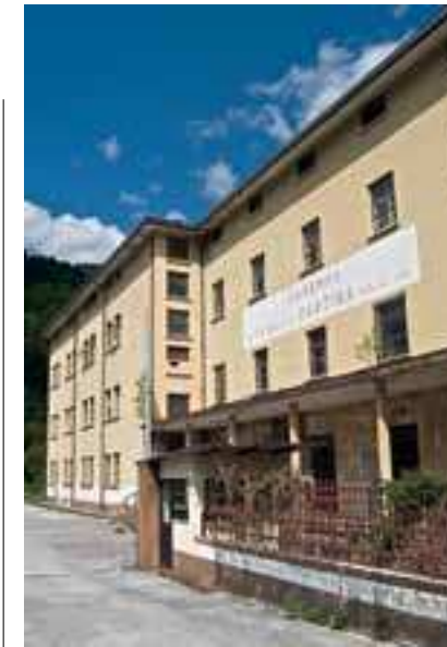
La caserma Egidio Fantina a Pontebba. Costruita in età da guerra fredda, verrà demolita per far posto a una lottizzazione di residenze con struttura in legno. Fotografia di Walter Coletto.
