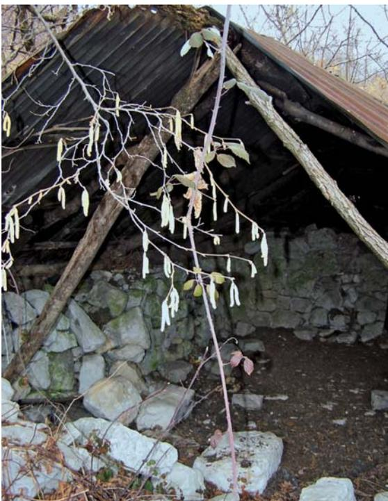
61. L'interno dell'edificio di Col Scussat con il basso profilo del muro testimonia una tecnica costruttiva a secco.
