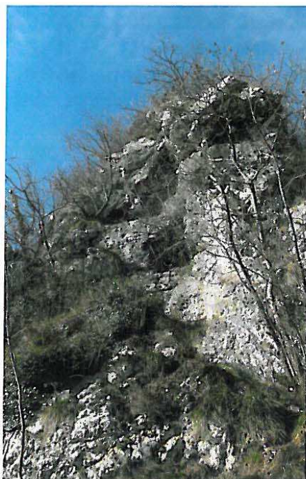
3. Veduta della parete e della cavità tamponata con la muratura in pietrame.
