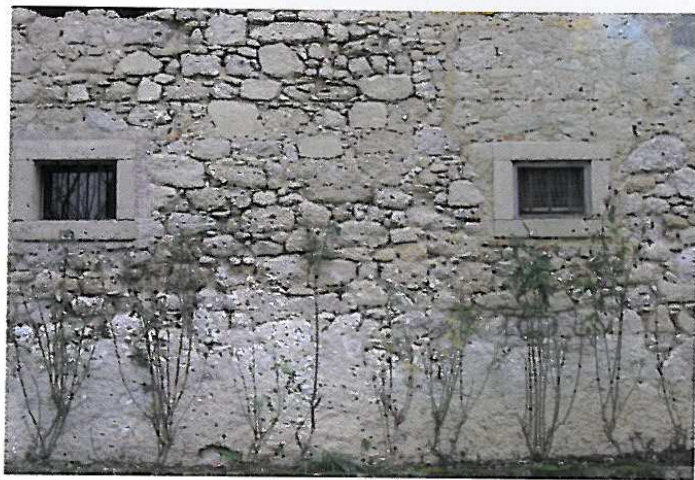
Muratura non corsata con pietre di conglomerato scarsamente modellate.
