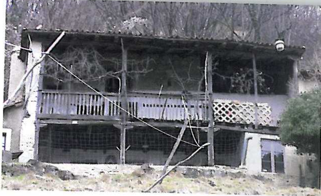
Casa di aspetto tradizionale con loggia molto profonda (poziol) retta dai due setti esterni in muratura e da due ordini di pilastri in legno.
