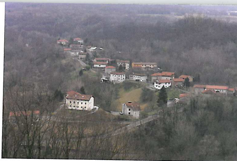
Strada e abitazioni si concentrano sul vertice dei colli argillosi, dove ci sono meno problemi di erosione.
