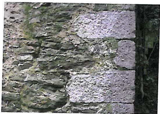
Muratura a Praforte con pietre angolari in calcare regolarizzate con lo scalpello e murature in arenaria con tessitura incerta.
