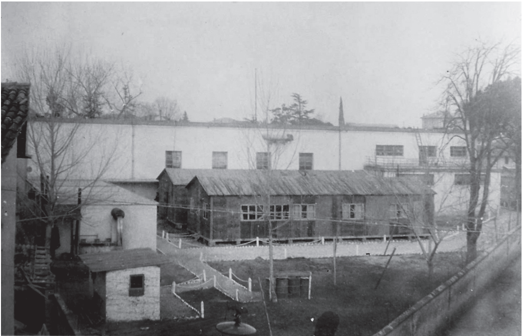
Il retro della Casa del Balilla è in parte nascosto dalle baracche in legno degli alloggi ufficiali (ASUd GI)
