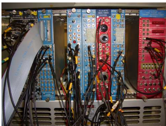
Figura 4.3: Moduli di logica NIM, inseriti nel crate di alimentazione.
