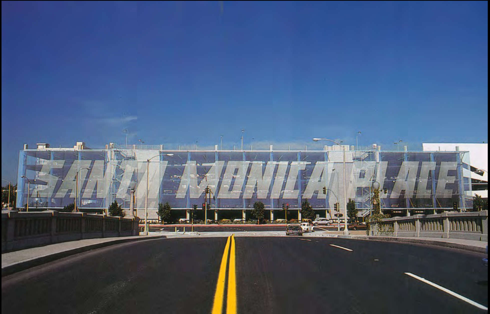
Centro commerciale "Santa Monica Place", Santa Monica (LA), 1972-80
