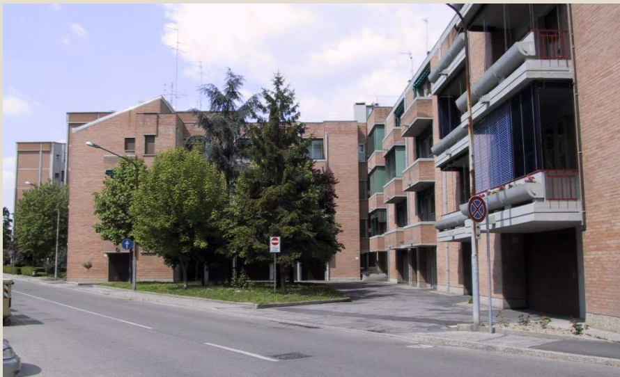
Quartiere Foro Boario, Ferrara. Le corti triangolari sul lato della strada.
