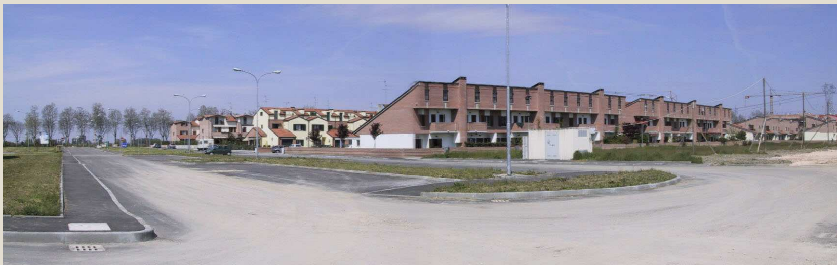
Quartiere Malborghetto, Ferrara. L'accesso al quartiere.
