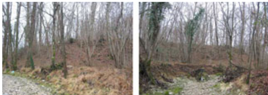
28. Il rilevato di terra visto da monte e da valle.
