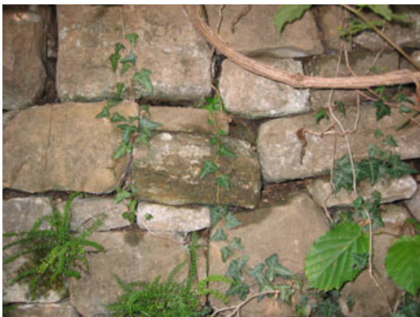
25. La tessitura ordinata dei muri di cinta principali.
