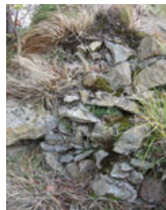
32. Resti di un muro a sacco ormai privo di paramenti murari.
